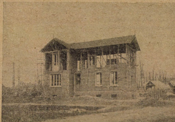
1. kép. Szalmaház építés közben. A födél előbb elkészíthető, mint a fal, úgy hogy a munka a födél védelme alatt történik.
