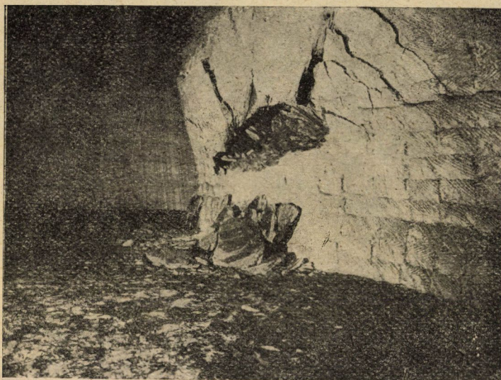
4. kép. Megroppant sófal a Rudolf-akna 140 m-es szintjében. (Szerző fényképfőlvétele.)
