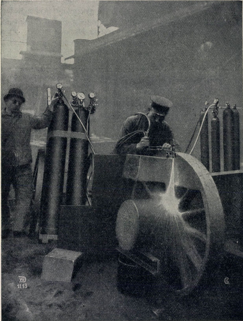
2. kép. A túlöntés levágása nagyobb darab öntvényről.
