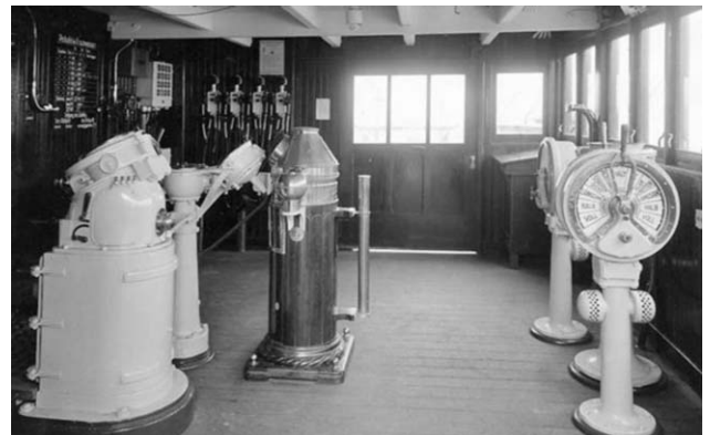
17. ábra. Pörgettyűs Anschütz-Kämpfe műszerek (bal oldalon és középen), egy régi hajó parancsnoki hídján.
