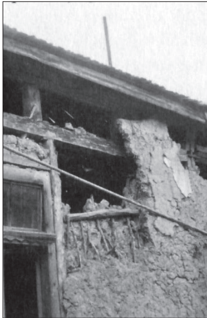
2. ábra. Tapasztott sövényfal, Szabéd (fent), favázás, sövényfalas ház, Szék (lent)
