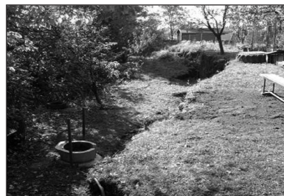
4. kép. Ivó utcával párhuzamos szakadás 1/1 (2010-10-13) (Forrás: Sycons Kft.)
