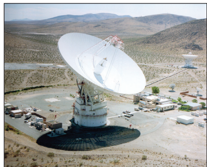
A hatalmas távolság miatt a New Horizons adását a NASA legnagyobb követőantennájával, a goldstone-i 70 méter átmérőjű parabolával veszik
