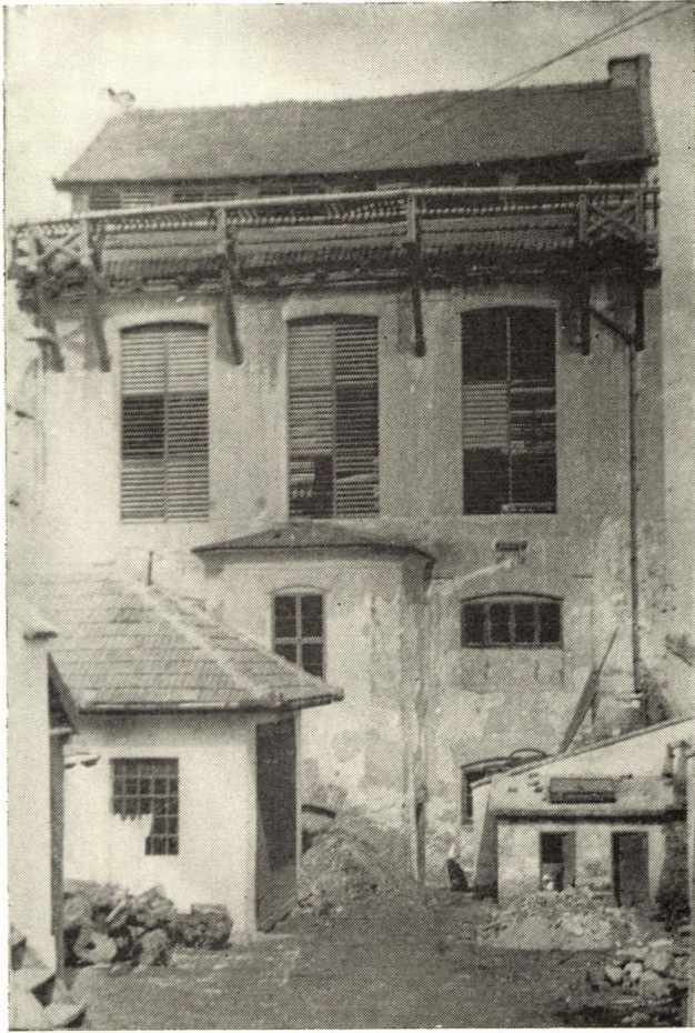
1. A pápai volt Kluge-féle nyomóüzem főépülete mai állapotában. Fenn szárítótér, az I. emeleten a nyomóüzem, a földszinten a festőde volt
