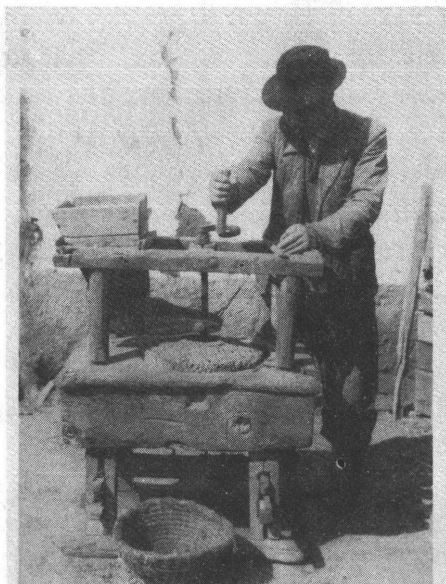
18. Darálás tengely hajtású garatos kézimalommal. (Nyírmártonfalva, Szabolcs m.) ÚJVÁRI Zoltán felvétele 1957
