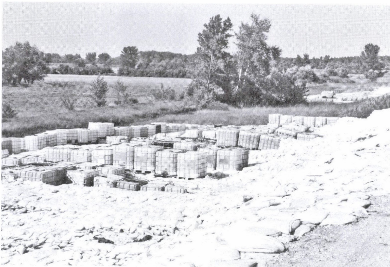
4. kép. Homokzsákos és víztartályos védekezés a töltés rézsűcsúszásánál
