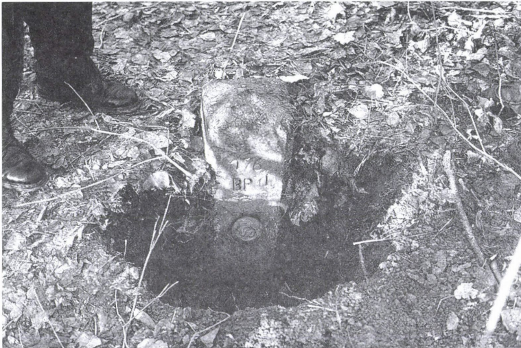
5. kép. Vezensy Tisza bal parti hullámterén a régi kilométerkövet a nagyvizek hordalékanyaga 70 cm vastagágban temette el
