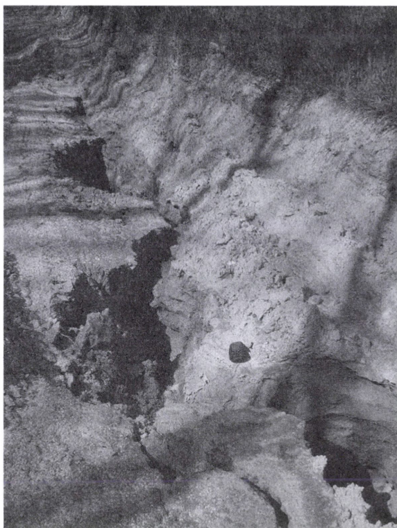
3. kép. Mélyút Jazvina-pusztá közelében. Az út jobb oldalán bevágódó mély eróziós barázda az oldalfal omlását készíti elő
