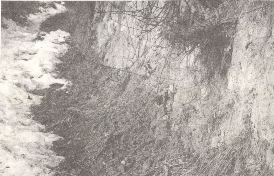
2. kép. Omlásból és pergésből származó akkumulációs törmelékkip sor egy löszfal lábánál Accumulation debris fan deriving from toppling and granular disintegration on loess bluff feet
