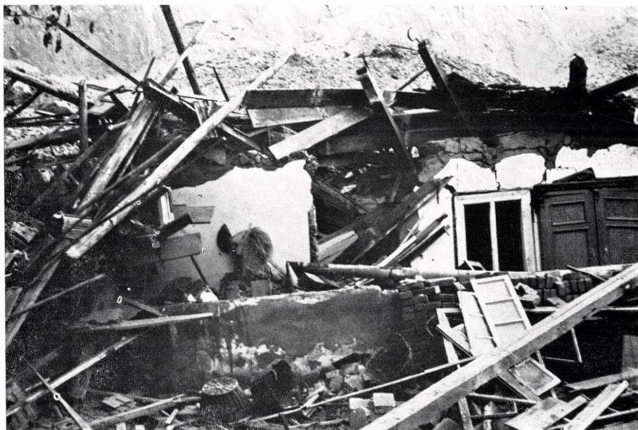
9—10. kép. Földesuszamlás szakadásfrontja mentén kettévált ház Dunaföldváron House split into two by the main scarp of slide at Dunaföldvár
