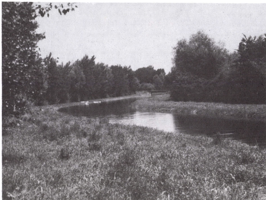
2. kép. A Győrzámoly melletti csatornázott meder vonala Line of the pipe-drained channel near Győrzámoly
