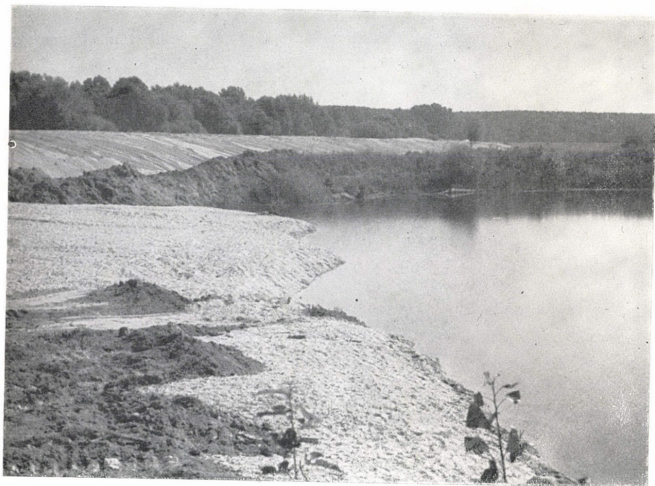
4. kép. A Kőszegi-tó feltöltése. Bal oldalon a tó egy részét már feltöltötték kavicsal. Háttérben a töltés erősítése és a Duna árterének erdősége látszik (Foto: GÖCSEI J.)
