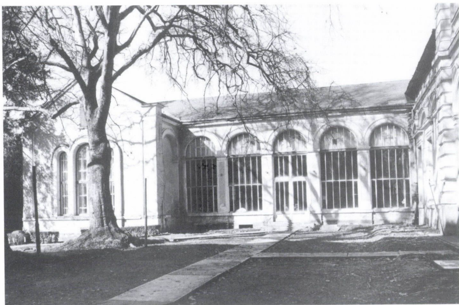
16. Füzerárvány. Károlyi-kastély. Északi keresztzárny, déli homlokzat, 1995
