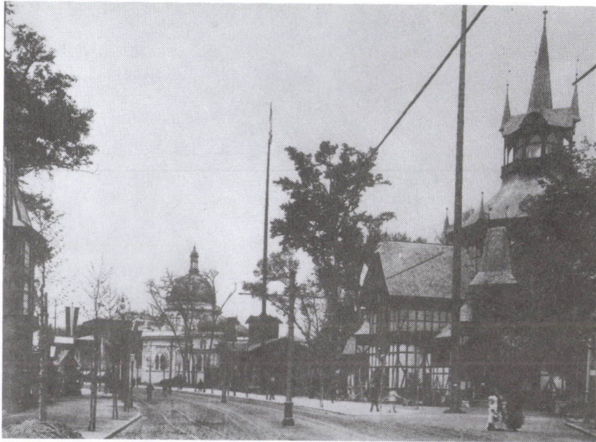
15. Ezredéves kiállítás: a kiállítási körút (BTM Kiscelli Múzeum, fényképtár: 15.770/26)
