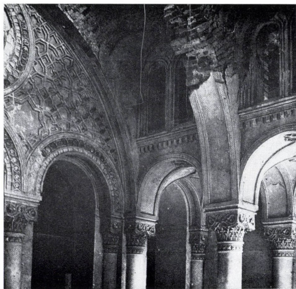
37. Vörösvár (Rotenturm), Erdődy-kastély, az előcsarnok részlete. (Fénykép a jelenlegi állapotról)
