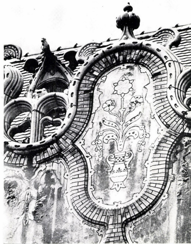
38. Lechner Ödön: Postatakarékpénztár, a főhomlokzat részlete
