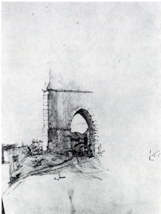
Fig. 4. Alte Minoritenkirche: Westturm, Erdgeschoß. OMF (vor 1918)
