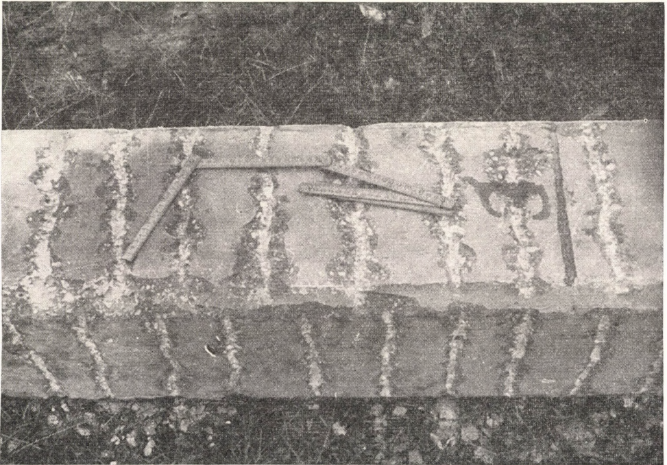
Bild 3. Vorgefertigter Pfahl 30 \times 30 \times 600 cm mit Rillen an dem Betonmantel
