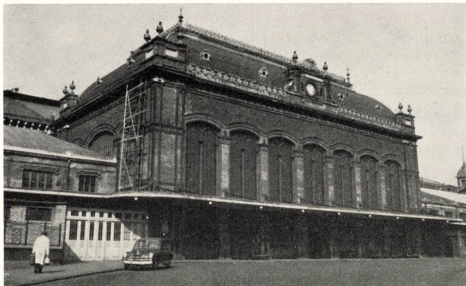
Abb. 12. Budapest Nyugati pályaudvar (1874—77). Der Bau zeigt die Formen der zeitgenössischen französischen Architektur
