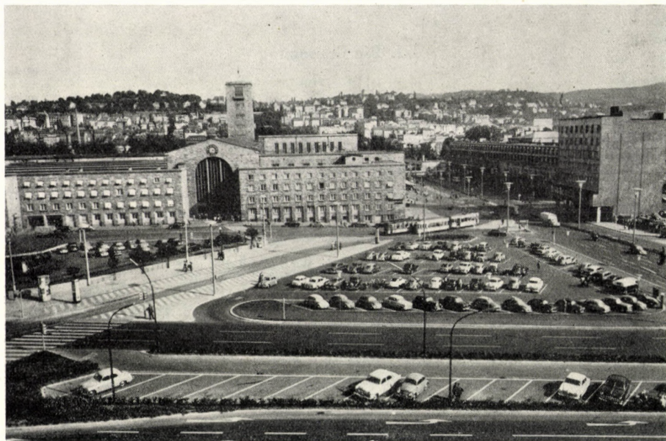
Abb. 16. Stuttgart (1911—1927). Der Hauptbahnhof von Schoeler und Bonatz war jahrzehntelang richtungweisend. Bild mit dem bezeichnenden seitlichen Vorplatz zur Bewältigung des Straßenverkehrs nach dem zweiten Weltkrieg
