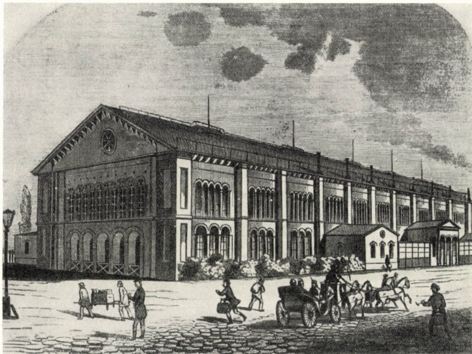
Abb. 5. Pest (1846). Fortschrittliches Bahnhofsgebäude von Matthias Zitterbarth d. J.
