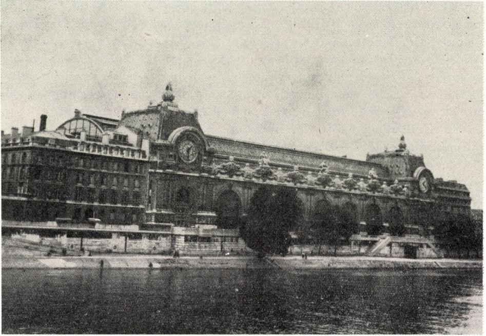
Abb. 14. Paris, Gare du Quai d'Orsay (1897—1900). Der Architekt Victor Laloux schmiegte seinen Bau mit spätteklektischen Formen in das Pariser Stadtbild
