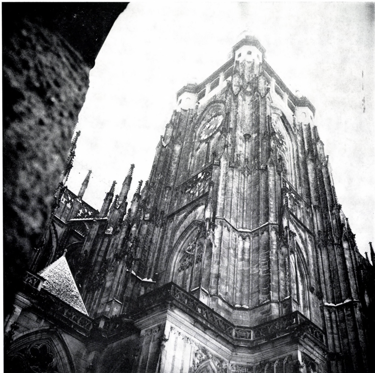
Abb. 18. Prag, Dom, Südwestecke des Südturmes. (Aufnahme Jan Bartušek)
