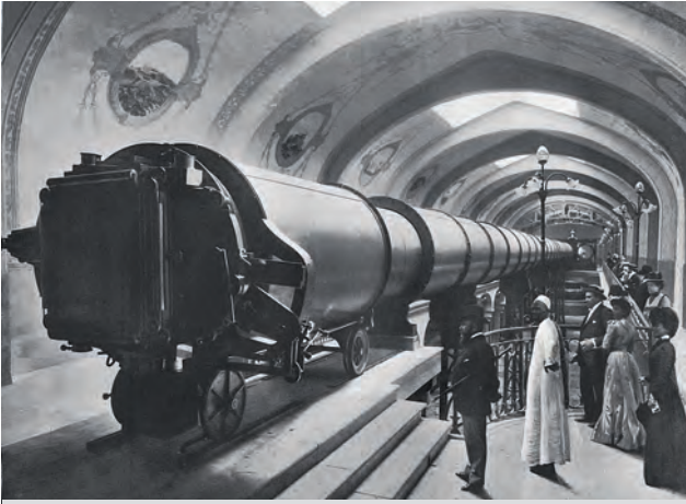
A valaha épült legnagyobb lencseátmérőjű (1,25 méter) távcső az 1900-as párizsi világkiállításon. A rögzített távcsőtubusba egy mozgatható tükör segítségével juttatták be a fényt.
