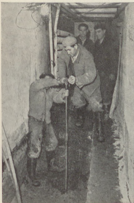
3. Fürt betoncölöp készítése kézfúróval
