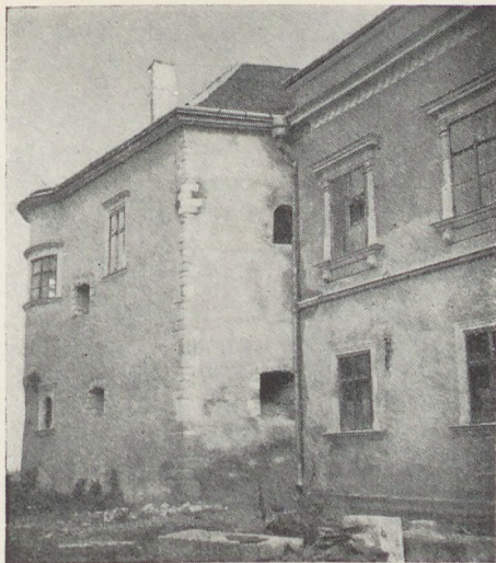
1. A várkastély ÉK sarokbástya a helyreállított lőrésekkel és sarokarmírozással, a restaurált Sub Rosa erkéllyel
