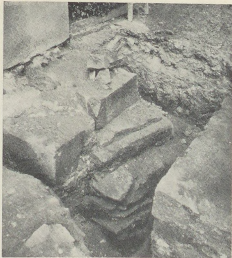
13. A külső vár újonnan felfedezett északi falszakaszának utca alatti maradványaiban talált gyalogbejáró, balról a gótikus támpillér sarkából lefaragott nyugati káva
