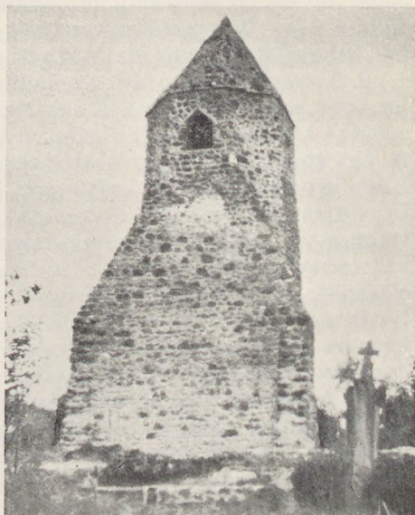
10. Szigliget. Avasi torony helyreállítás után. Kozák K. felv.
