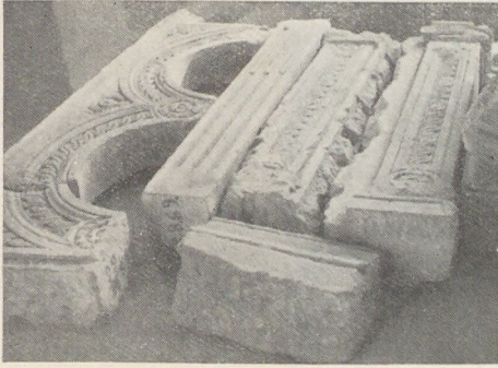
2. A reneszánsz ikerablak kibontott kövei. Az egyetlen megmaradt voluta és a tükrök meanderdíszé már cementhabarcsból készült kiegészítések
