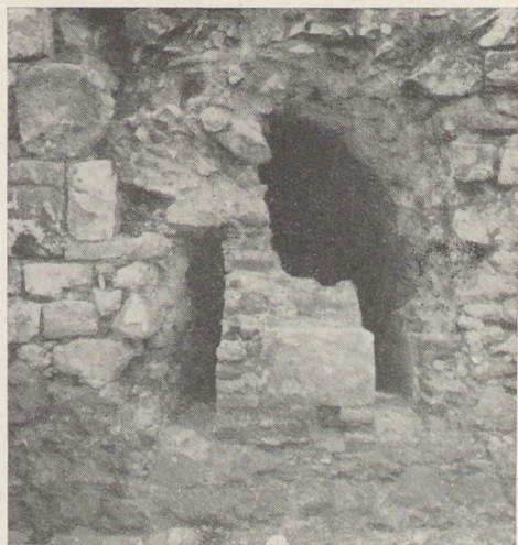
7. Kétágú lőrés feltárás után az Olaszbástya ÉK-i bástyakiszögellésén
