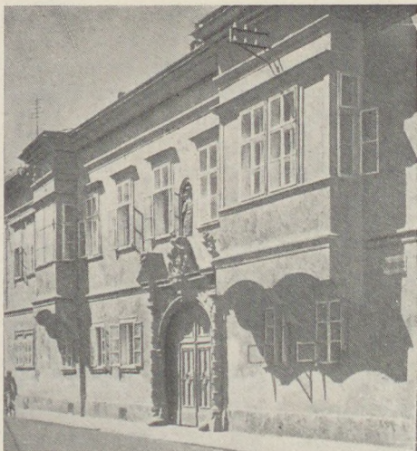
3. Templom u. 2. (v. Esterházy-palota) homlokzata. Erkélyek valószínűleg a középkorból származnak, kialakításuk a Kolostor utca 5-éhez hasonlít
