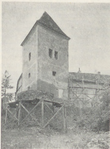
6. Kőszeg, Vár. Délkeleti külső saroktorony helyreállítása. Susits László felv.
