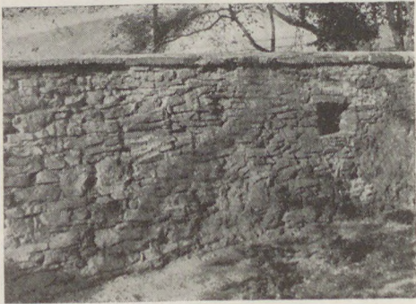
9. Szikszó, ref. templom kőkerítése
