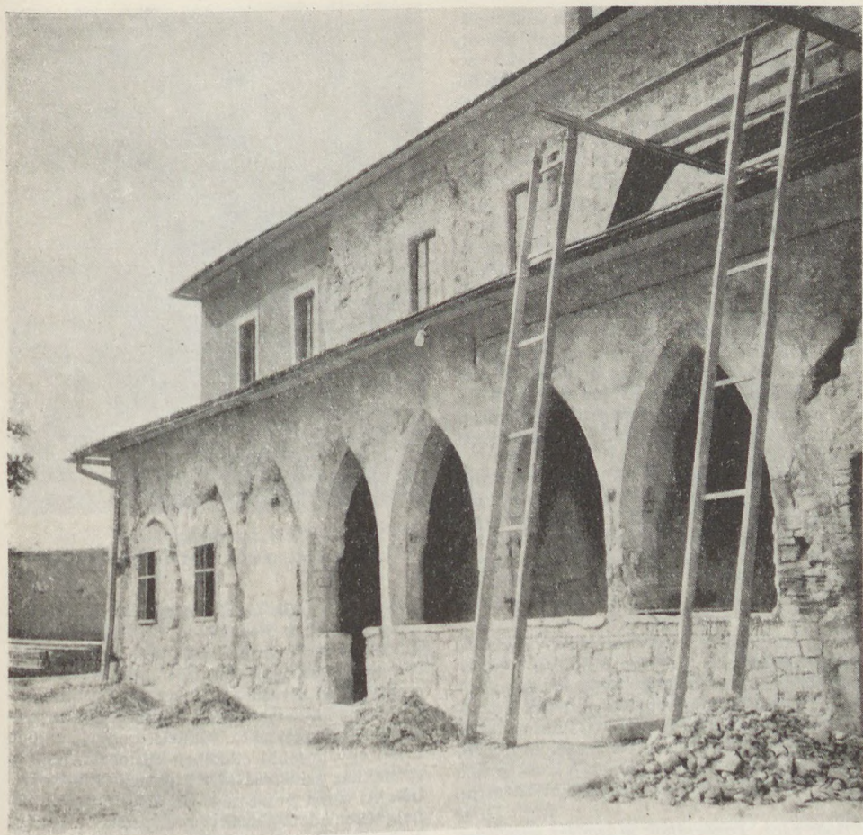
3. Az egri vár középkori épülete a Műemléki Felügyelőség által végeztetett helyreállítás alatt. A munkát megelőző tudományos feltárás (1958).
