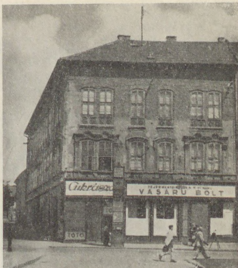
11. Székesfehérvári lakóház helyreállítás előtt
