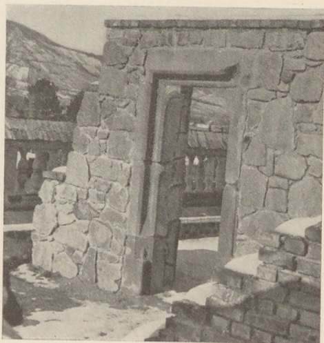
1. kép. A visegrádi palota gótikus kapuzata, eredeti sérült kövekkel helyreállítva.
