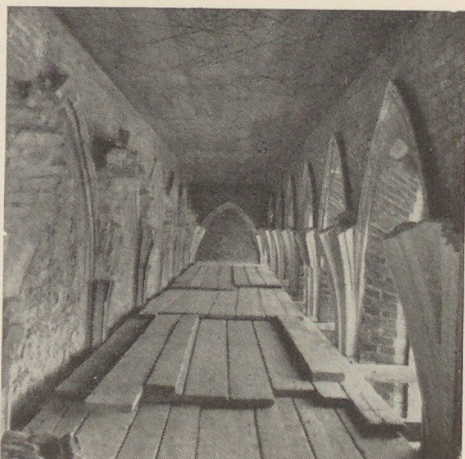
4. kép. A visegrádi palota kerengőboltozata helyreállítás közben
