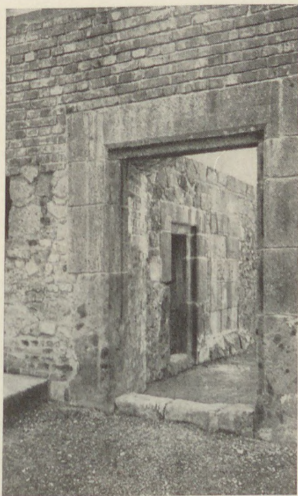
7. kép. A visegrádi palota egyik kapukeretének kiegészítése közűzálékos betonnal.
