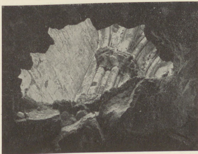
Zsámbék. A zsámbéki románkori templom előcsarnok boltozata beomlott. Javítása 1958-ban elkészül, továbbá a műemlék új kerítést és ört kap, új toronylépcsőt, és ez alkalommal kőtárát is rendezik.
