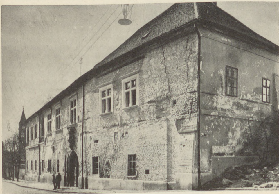
9. A ház a helyreállítás alatt (1956)
