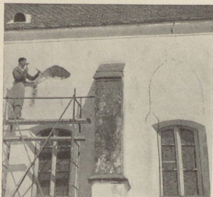
6. A gótikus szentélyablak bontása. A jobboldali ablak felett jól látható a csúcsíves repedés
