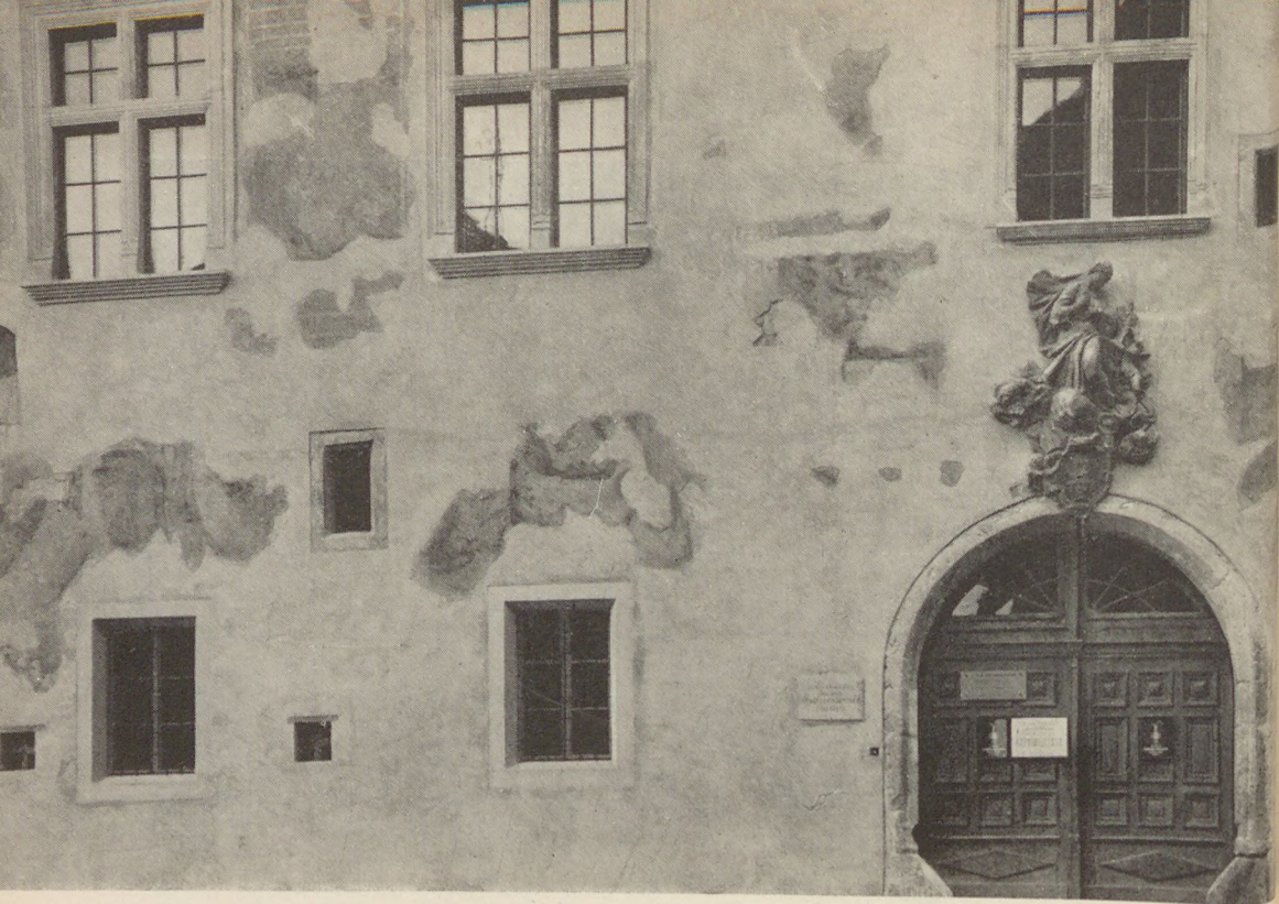
8. A helyreállított és rögzített freskók
