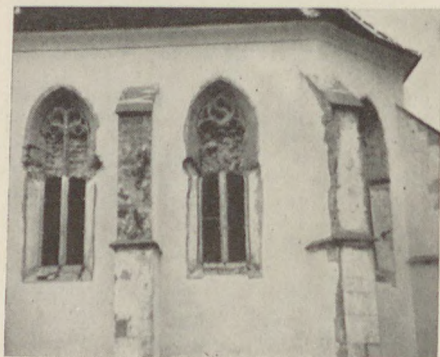
7. A kibontott gótikus ablakok az épen maradt kőrácsokkal (mérművek)
