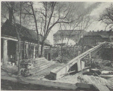
A nagy udvar keleti oldala helyreállítás közben
