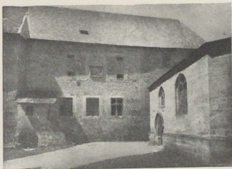
Koszt. Váruddvar a helyreállítás előtt
