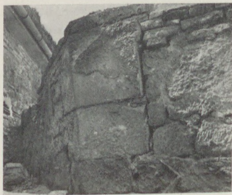
A török fürdő DK-i sarkának elmozdult kváderköve
