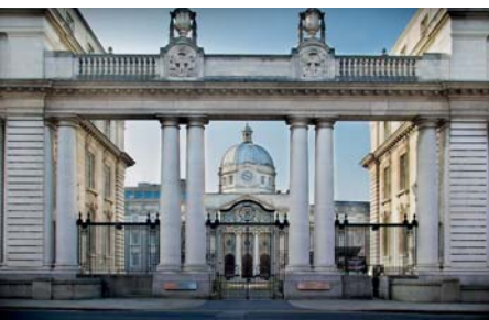
4. ábra. A Royal College of Science épülete Dublinban. A természet- és műszaki tudományokkal foglalkozó egyetem 1926-ban beolvadt az University College Dublin egyetembe. Az épületet jelenleg az ír kormányzat használja
