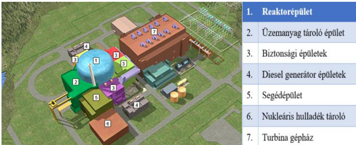
6. ábra EPR épületrendszer
