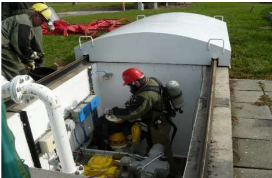
3. fénykép: Az alvállalkozó által végrehajtott vezeték leürítés.
