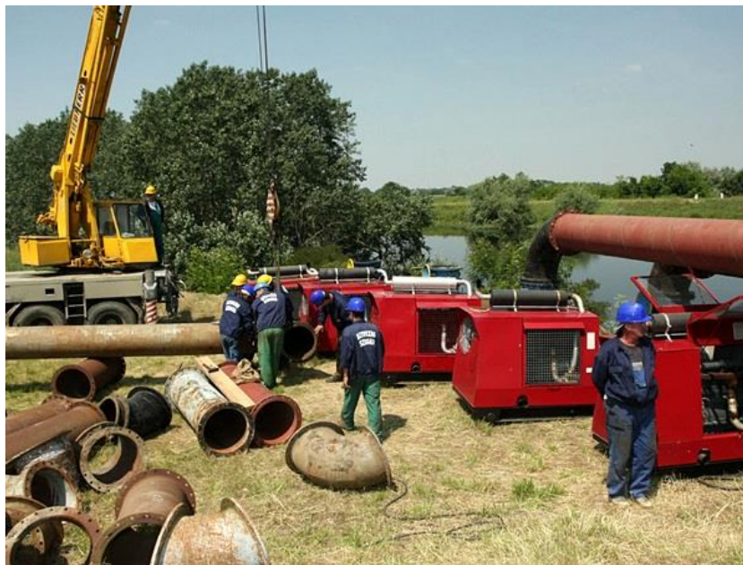
3. ábra: Mobil szivattyúk telepítése a Dong-éren 2010-ben [11]
