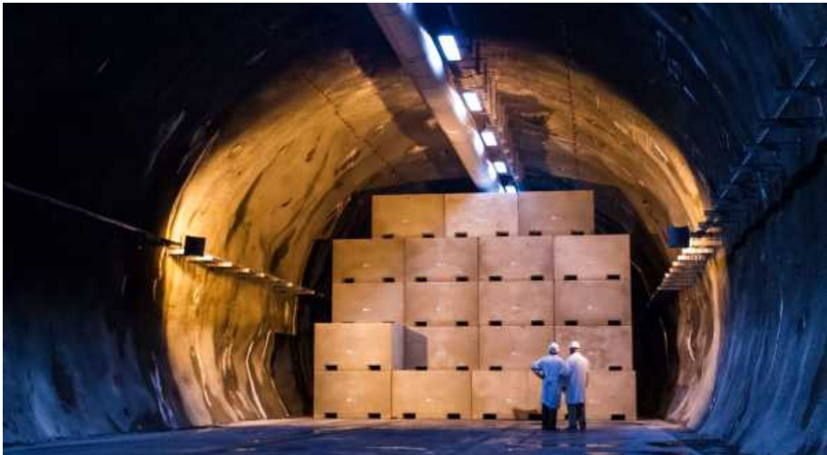
5. ábra. A Nemzeti Radioaktív Hulladék-tároló I-K1 kamrájában elhelyezett konténerek [9]
