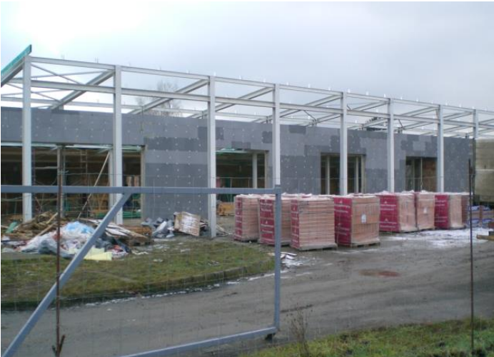
Készül a tetőszerkezet
