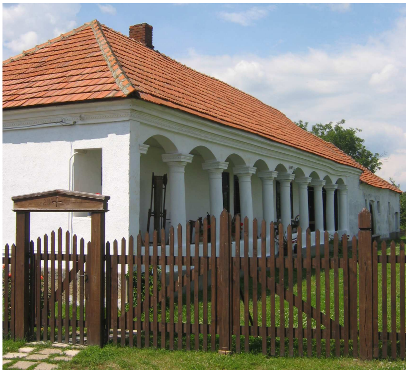
A Váralja u. 2. sz. alatti épületnek egykor oromfalas homlokzata volt, tervezzük a helyreállítását
