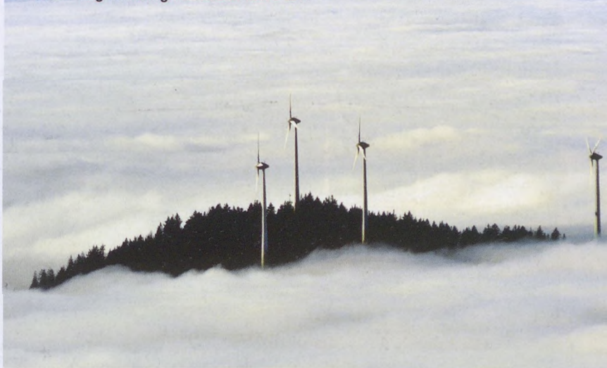
Szélturbinák magasodnak a felhők fölé a németországi Freiburg közelében MTI / EPA
