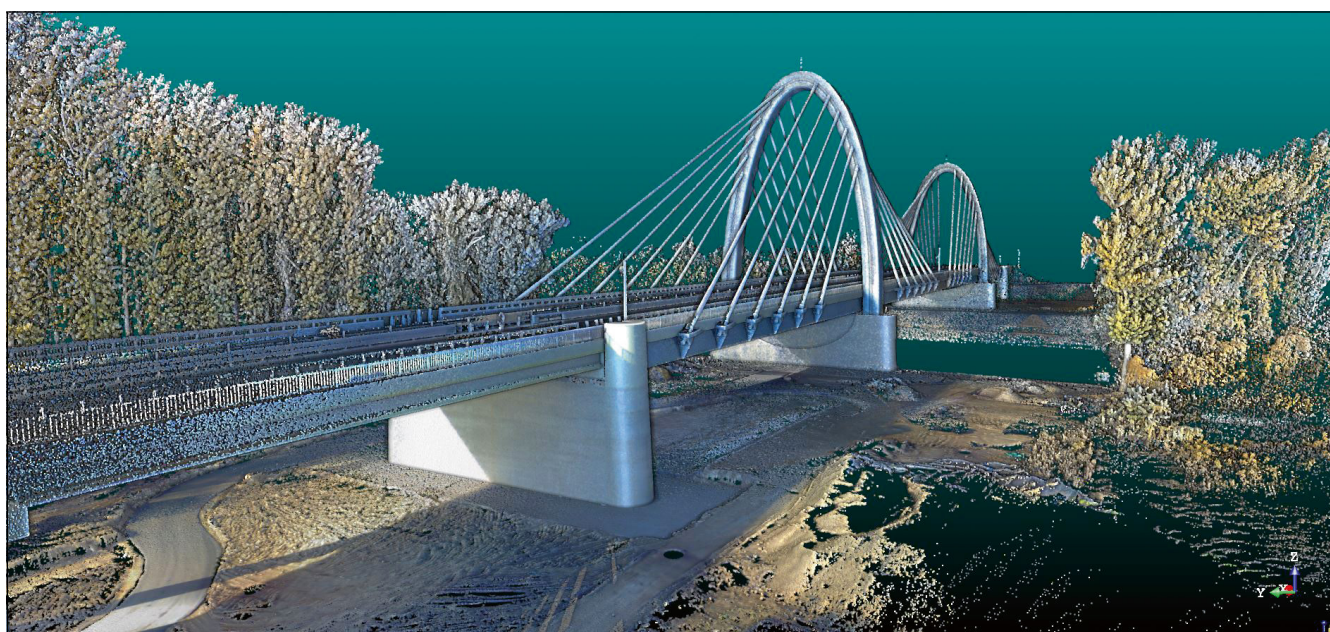
A Tisza-híd képe a pontfelhőből
