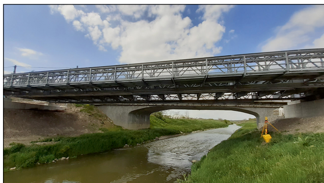
5. ábra. Az elkészült híd időszakos mozgásvizsgálati mérése
