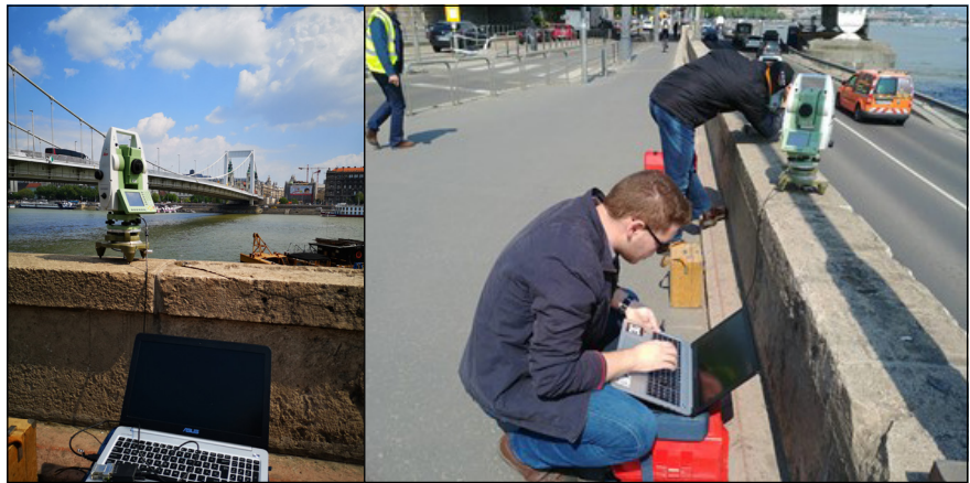
9. ábra. A vezérlés helyszíni tesztelése
