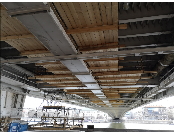
4. ábra. A DN600-as vezetékek építése
