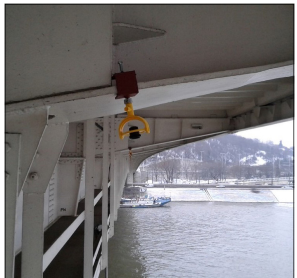
5. ábra. A keresztartón rögzített 46-MP típusú mini prizma
