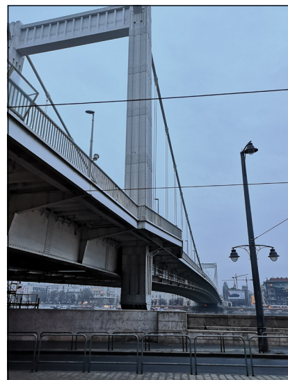
2. ábra. A híd mai állapotában
