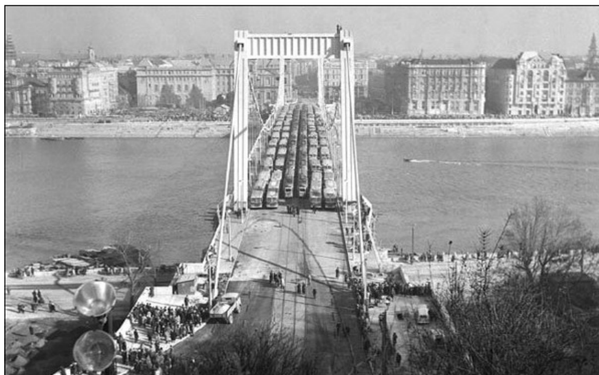
1. ábra. A híd próbaterhelése
