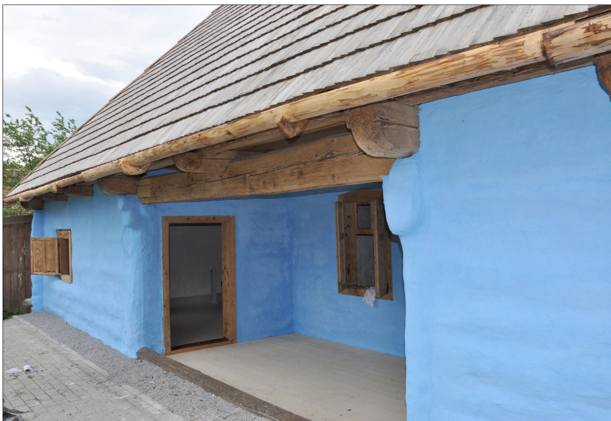
21. ábra Csíkszentdomokosi tájház épülete 1774-ből
