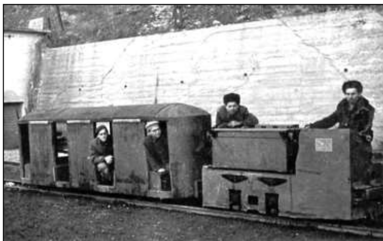
18. kép. AEG gyártású, akkumulátoros bányamoszdony és személykocsi
