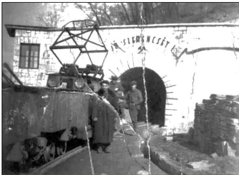
12. kép. Felsővezetékes villamosmozdony
