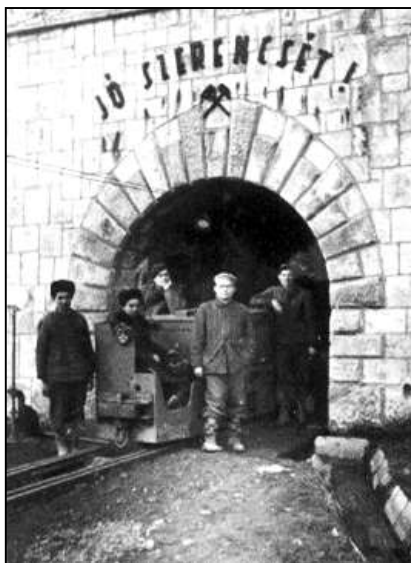
19. kép. AEG gyártású akkumulátoros bányamozdony az altáró előtt
