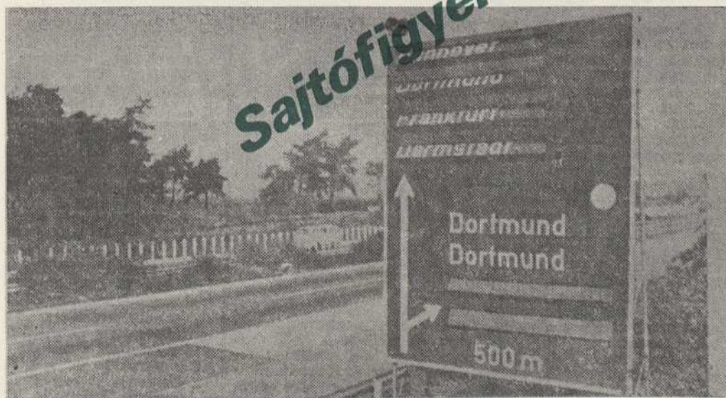
A számítógépes forgalomirányító rendszer egyik információs tábláját láthatjuk, amelyen az időről időre változó kiírások a kevésbé igénybe vett útvonalakat jelzik.
