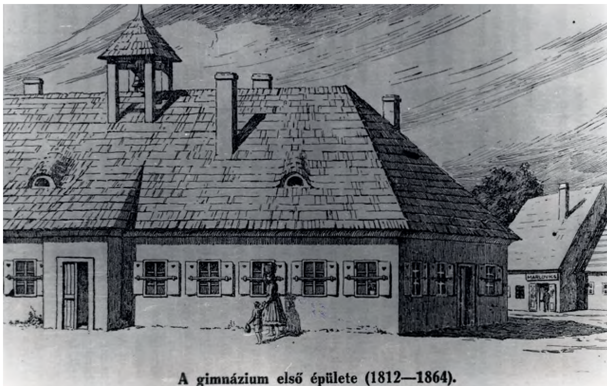
1. ábra. A gimnázium első épülete (1812-1864) rekonstrukciós rajz, 1962 Rippl-Rónai Múzeum Történeti fényképgyűjtemény. Reprodukció Isz.: 7003
