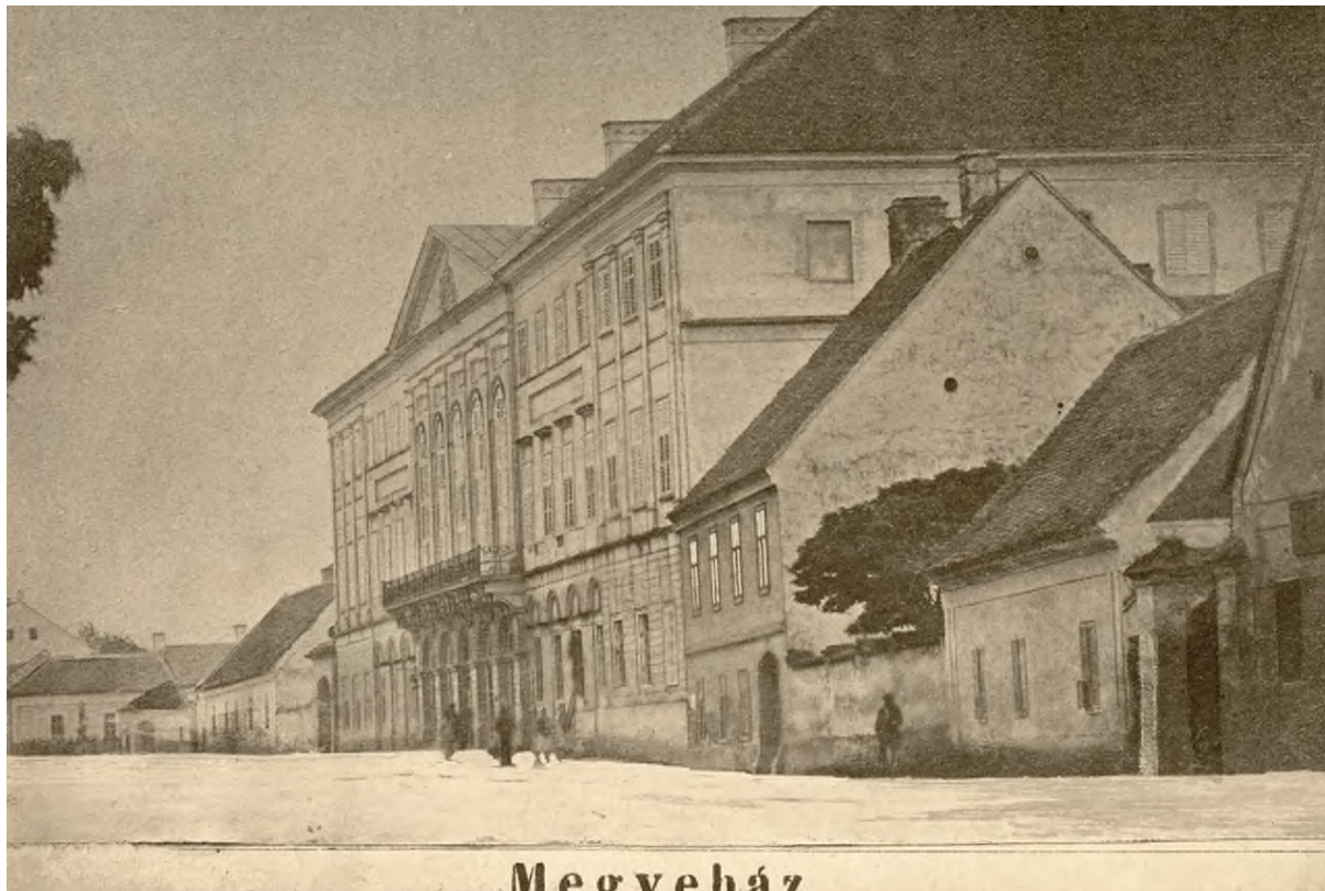
2. ábra. A kaposvári régi, klasszicista megyeháza (ma a Somogy Megyei Önkormányzat és a Rippl-Rónai Múzeum épülete) Langsfeld Mór felvétele 1873 Rippl-Rónai Múzeum Történeti fényképgyűjtemény. Isz.: 3379
