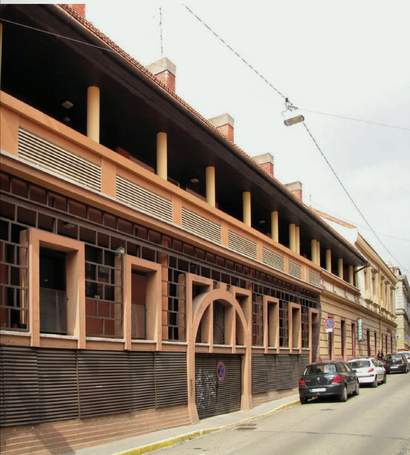
Villámsújtotta ház, Pécs, Építész: Dévényi Sándor, 1978-1985 (Fotó: Kovács Dániel / Wikimedia Commons)
