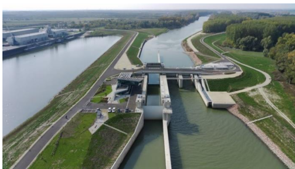
7. kép. Mosoni-Duna torkolati műtárgy (ÉDUVIZIG felvétel)
