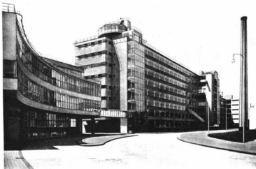
Brinkman és Van der Vlugt: A van Nelle gyár épülete Rotterdamban. 1930
