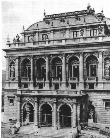
1. AZ OPERAHÁZ HOMLOKZATA A LEÁLLVÁNYOZÁS UTÁN.
