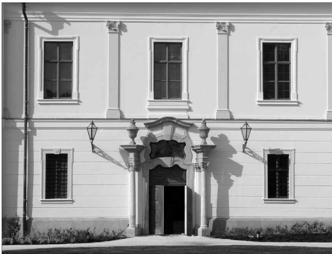
A homlokzat helyreállítása a korábbi gyakorlat szerint történt
