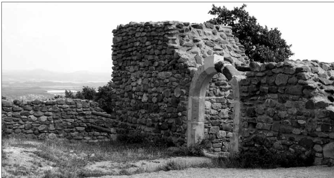
A törmelékből előkerült kőanyagot visszaépítettük a falakba.
