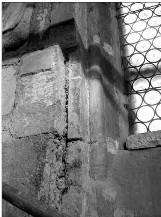
Az északi fal egyik ablakának alsó sarkából az eredeti bélétréteggövek elé helyezett, a falvastagítást szolgáló utólagos kőlapozással
