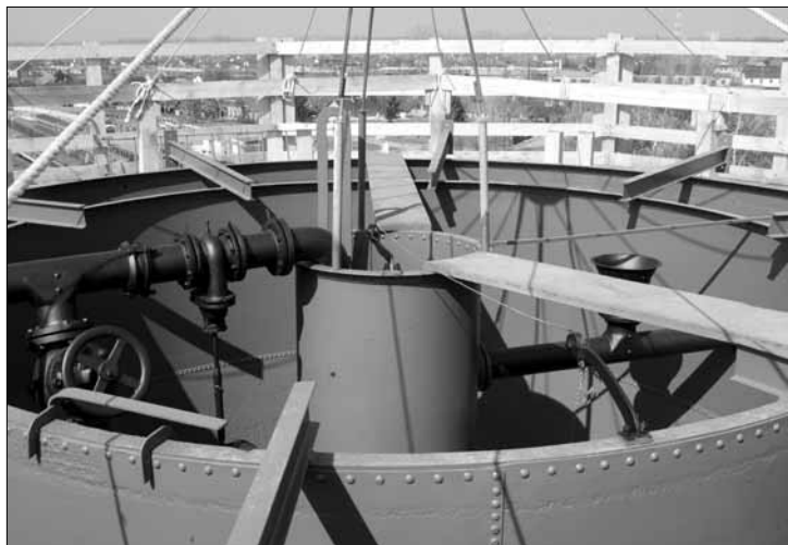
Az 1900-ban épült Intze-féle víztoronyban lévő 120 m 3 -es víztartály helyreállítása
