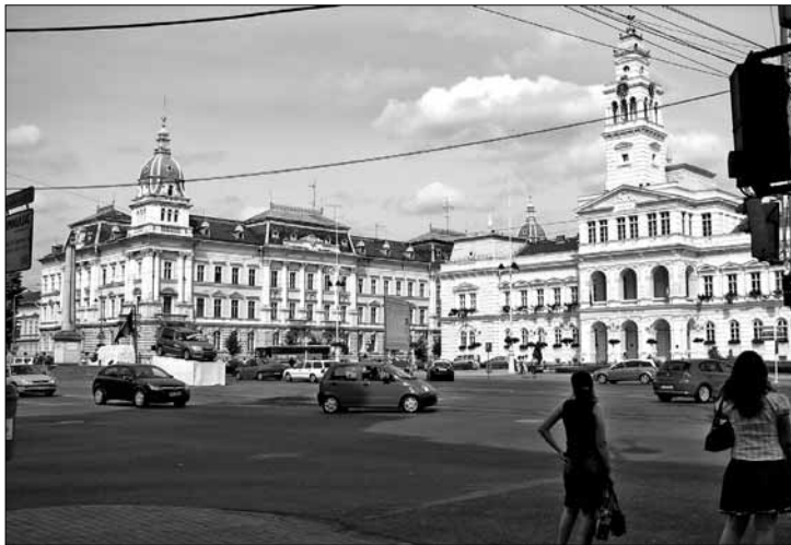
A főtér – közép- pen a Városi Tanács épülete
